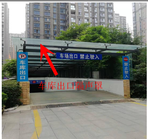
图 14 车库出口隔声罩
